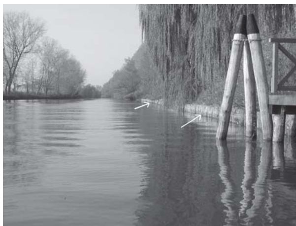
Fig. 5. Palificata di sostegno (frecce) contro l'erosione delle rive: fiume Sile.
