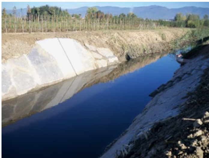
Fig. 37 – Veduta dell'opera di presa e relativa scogliera di protezione.
