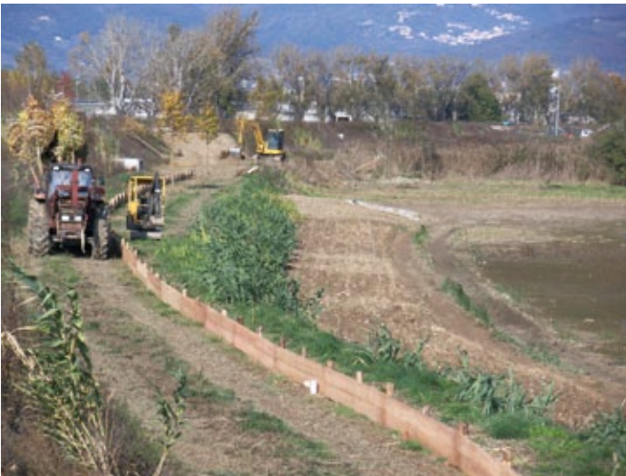
Fig. 40 – Realizzazione della fascia tampone vegetata.
