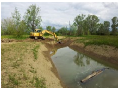
Figg. 46-47-48-49 – Rimodellamento del fondo lacustre e realizzazione di isolotti per la nidificazione.
