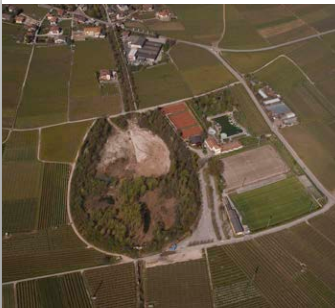
Geschieberückhaltebecken: eine echte Ressource
