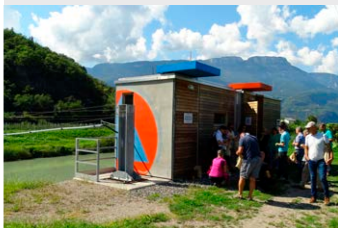
Stazione idrometrica Ponte Adige
